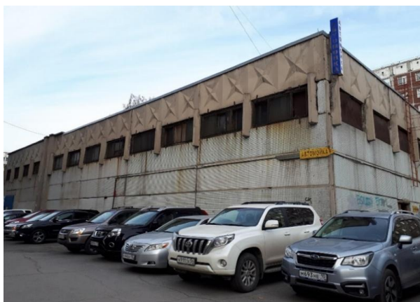
Рис. 10. Здание ЦТП, переоборудованное под станцию технического обслуживания с автомойкой (Новосибирск)
