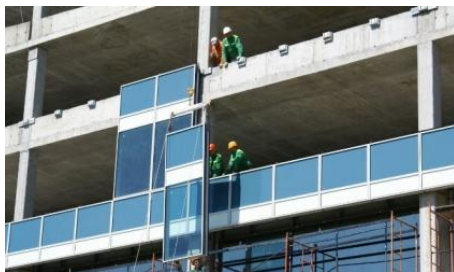
Рис. 3. Схема устройства фасадов модульным методом
