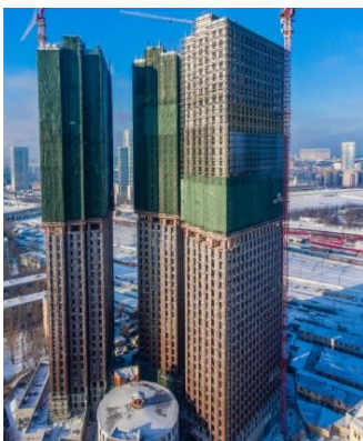
Рис. 2. Установка лесов в два яруса на высотном здании
