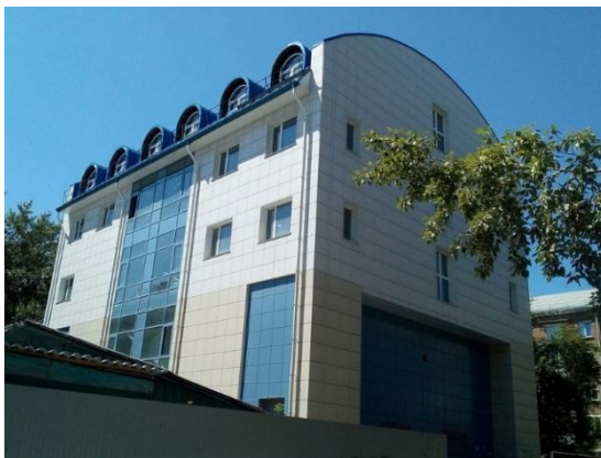
Рис. 5. Здание ЦТП, реконструированное под центр технического творчества (Новосибирск)
