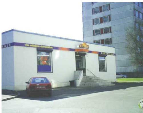
Рис. 1. Здание ЦТП, реконструированное под зоомагазин (Рига, Латвийская Республика)
